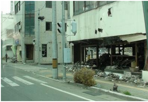
写真③ 被害を受けた釜石市内の商店街
