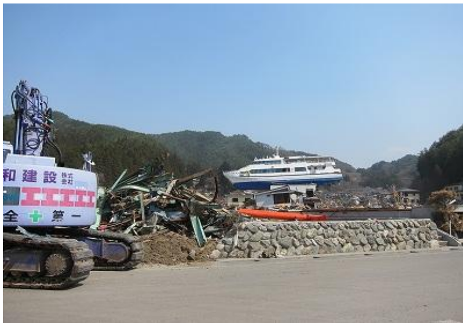
建物の上に乗ったままの船（岩手県大槌町にて）
